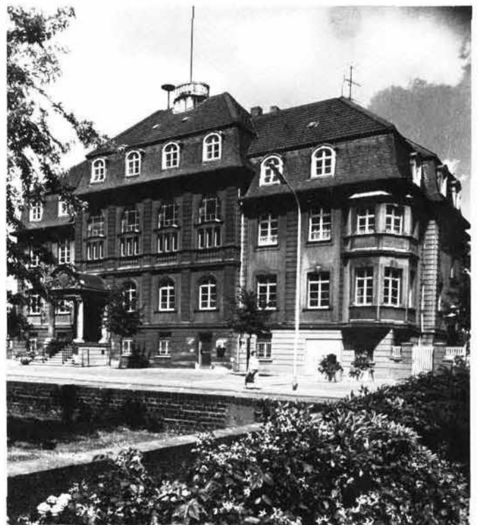
Die ehemalige Bürgermeisterei Brühl-Land besaß in der Stadt Brühl ein repräsentatives Verwaltungsgebäude, das auch heute noch der Stadtverwaltung als Rathaus II dient.
